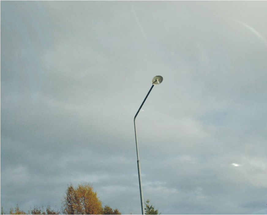
Exempel på eftersatt underhåll, kupa saknas, felaktig ljuskälla. Foto: Henrik Gidlund
