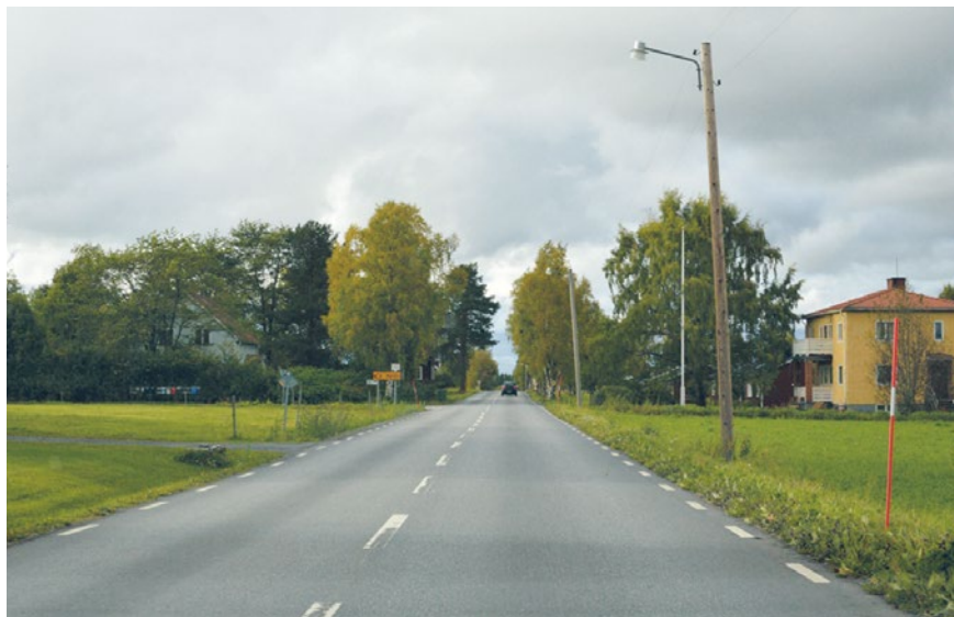
Äldre belysningsanläggning längs statlig väg. Foto: Henrik Gidlund
